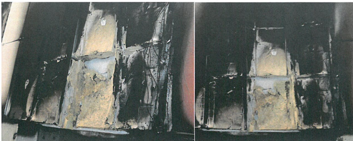
Rys. 33. Widok próbki po badaniu – detale, c.d.
