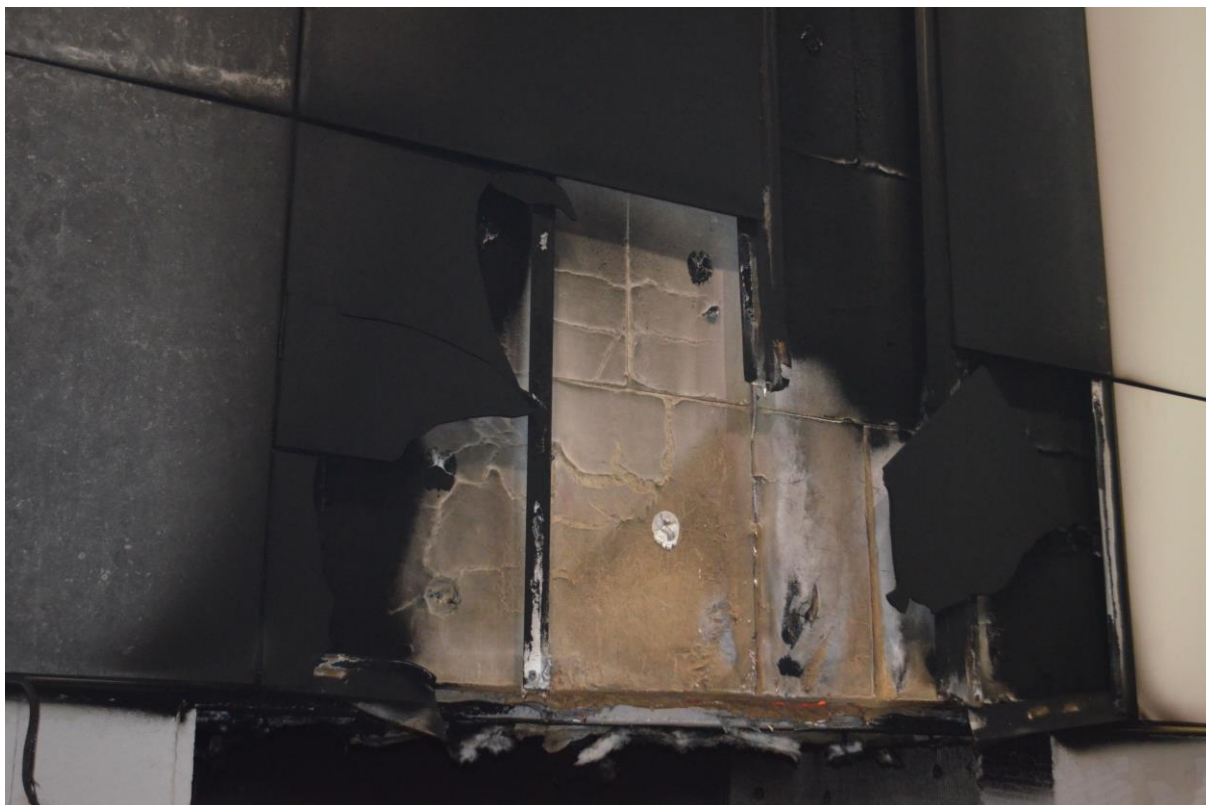
Rys. 12. Widok elementu próbnego po badaniu - data1
