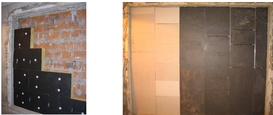
Fot.3. Ściana bazowa z izolacją systemową BSP Bracket System Polska, zamontowana w otwór badawczy komór sprzężonych. Od lewej: widok ocieplenia w trakcie montażu, widok gotowej przegrody - próbka nr 2.
