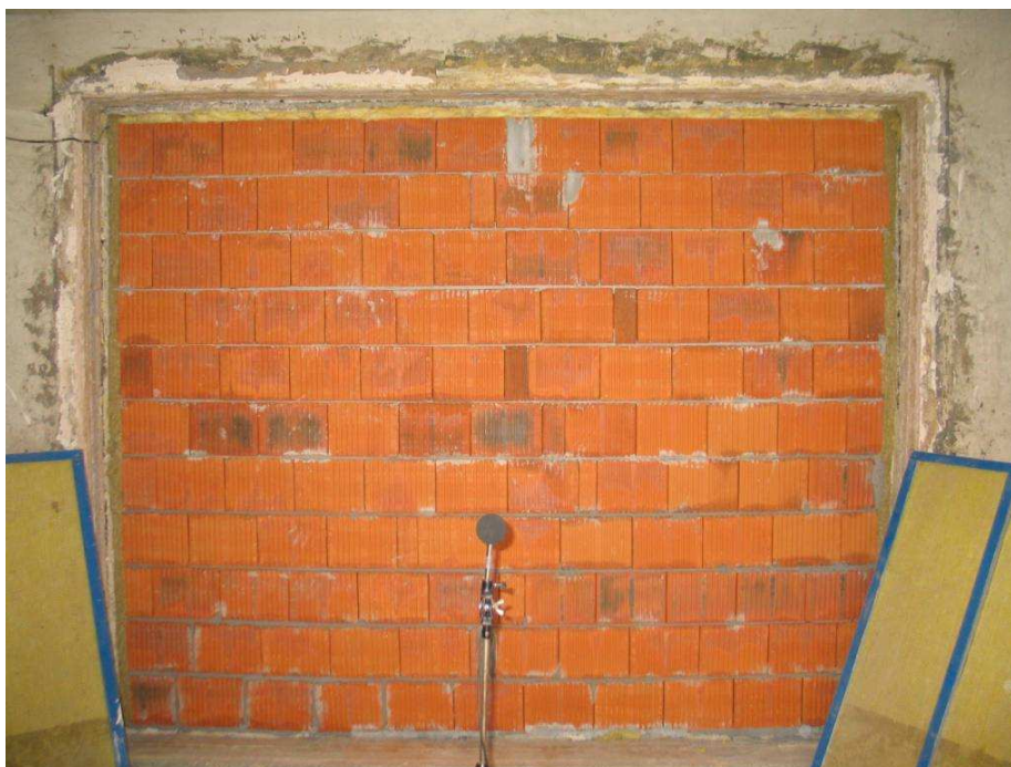
Fot.1. Ściana bazowa wykonana z pustaków ceramicznych MEGA-MAX 240 P+W gr. 24 cm produkcji Cerpól-Kozłowice Sp. z o.o., wmurowana w otwór badawczy pogłosowych komór sprzężonych. Widok od strony komory nadawczej.
